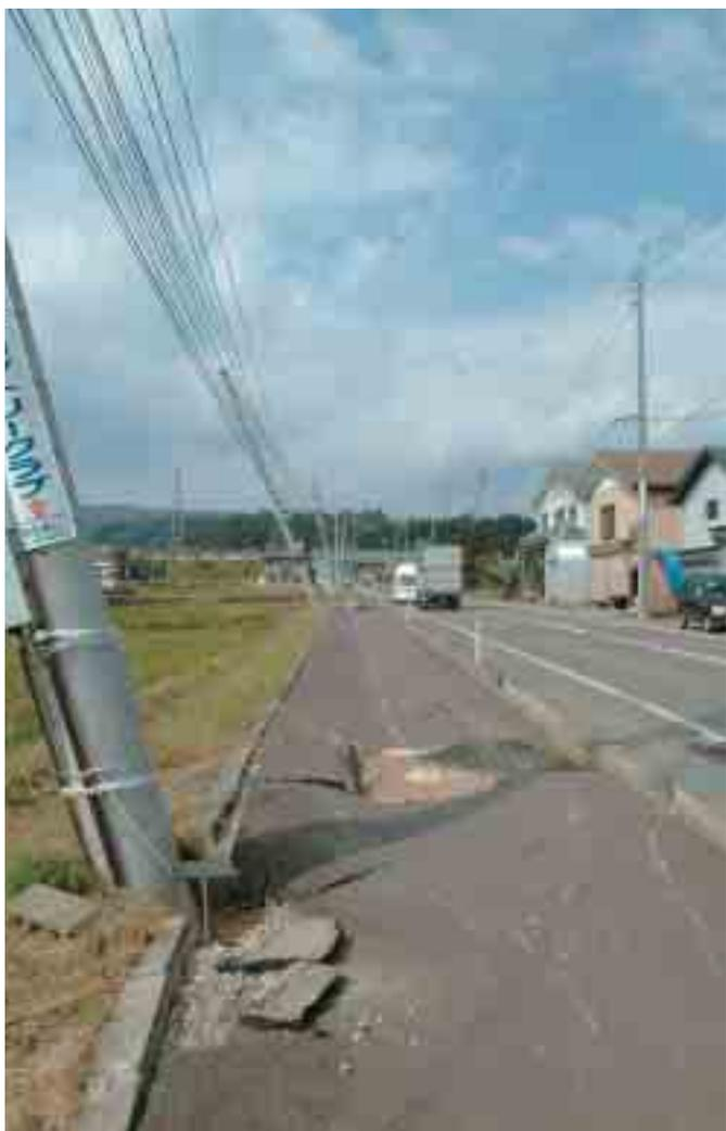
電柱が大きく傾き道路に亀裂が走る桜町地内
