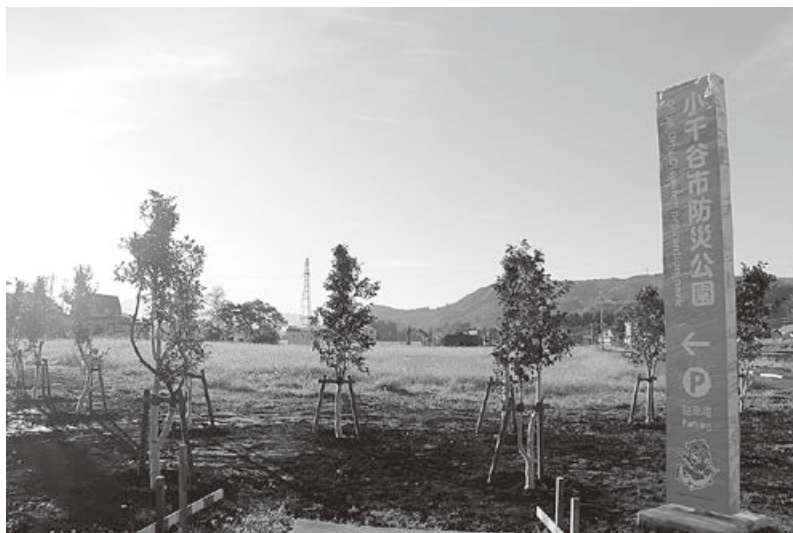
整備中の防災公園
