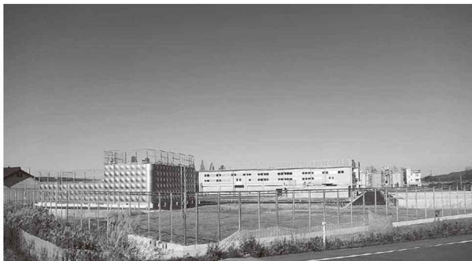
新浄水場外観
