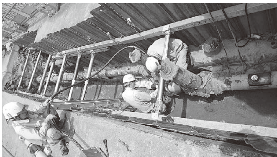
ガス管の維持補修工事
