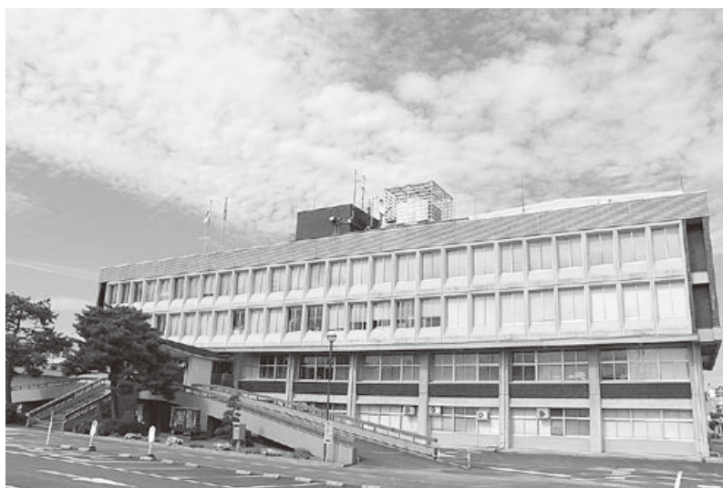
市役所庁舎外観
