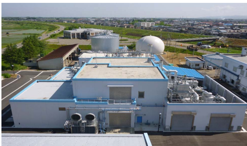
生ごみバイオガス発電センター
